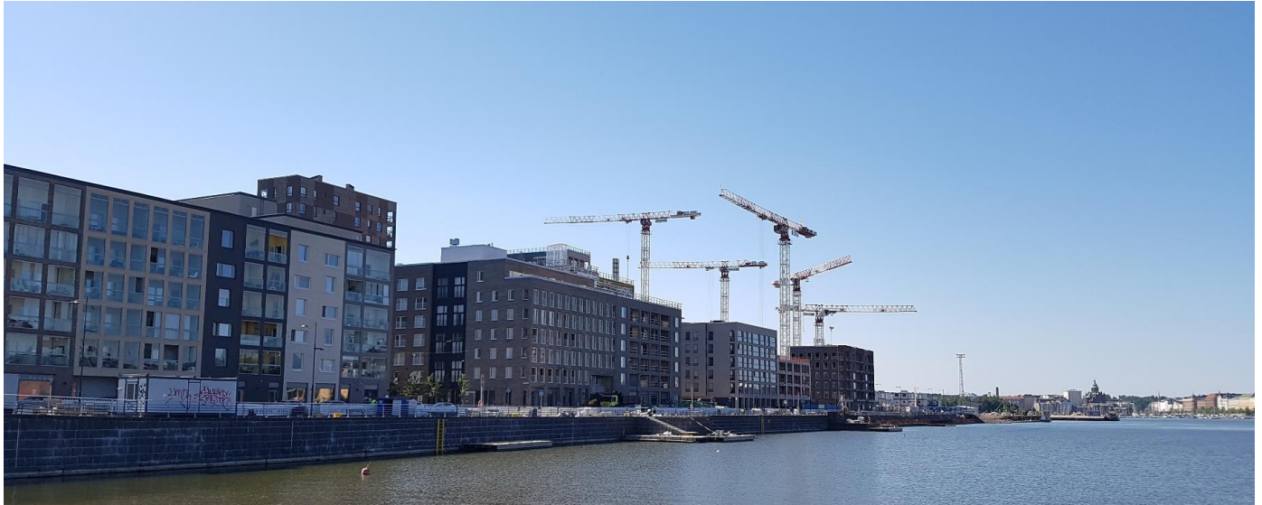
Asuntosäätiön SunZEB-rakennus on toinen rakennus oikealta ja sijaitsee Kalasadaman Sompasaassa.
